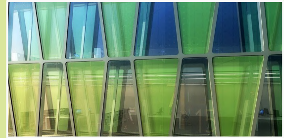
Façade panneaux d'algues
